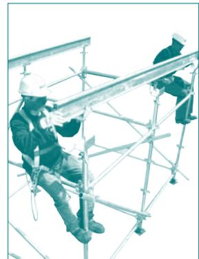
**10.** Cuando existe un traslape de vigas, se debe reemplazar las gatas J por gatas multivías, las que soportan la instalación de dos vigas a la vez.
