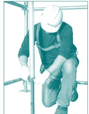
16.3 Una vez que los puntales de realzaprimado se han instalado, se procede al descimbre de la losa retirando el equipo principal.
