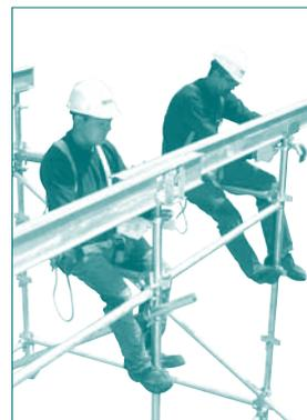
**11.** En el montaje de las vigas secundarias, se debe respetar la distancia indicada en el plano, lo que en ningún caso puede superar los 61 cm. Cuando las vigas están en voladizo, se deben fijar utilizando el clip universal con el fin de evitar su desplazamiento.
