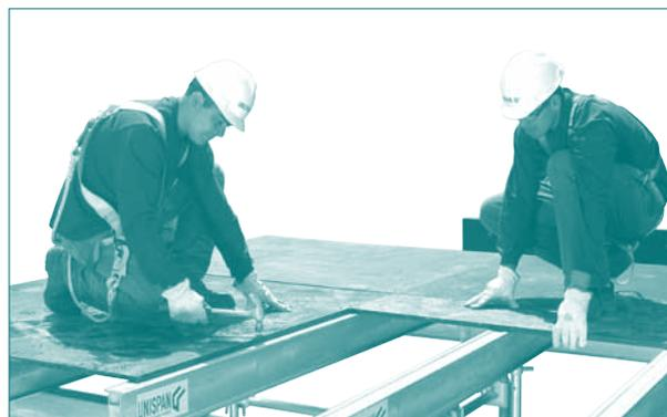
**13.** Bajo la unión de placas instaladas en forma longitudinal, se debe asegurar la colocación de una viga secundaria (traslape de vigas de aluminio).
