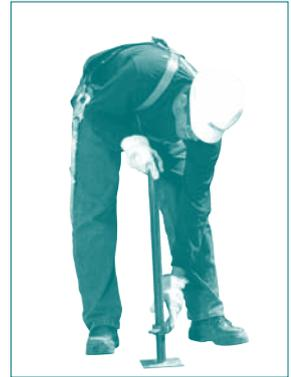
2. Inserte el puntal, asegurándose que el extremo largo quede hacia arriba. En caso de usar placas base en lugar de gatas base, el ajuste de altura sólo se regula con las gatas en el extremo superior del puntal.
