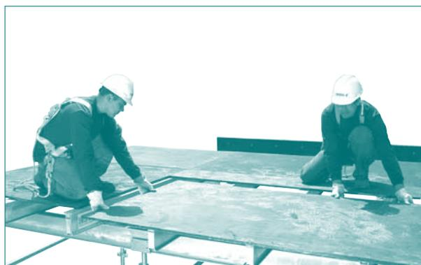
**14.** En los muros perimetrales que confinan la losa se deben instalar listones de madera (soleras) con el fin de fijar las placas de la losa a los muros y de esta forma evitar el movimiento horizontal.
