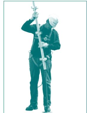
3. Mientras los armadores mantienen verticales dos puntales, deben insertar un travesaño en las estrellas inferiores de los puntales, para configurar un marco. De la misma forma, se inserta un segundo travesaño en las estrellas superiores de ambos puntales.
